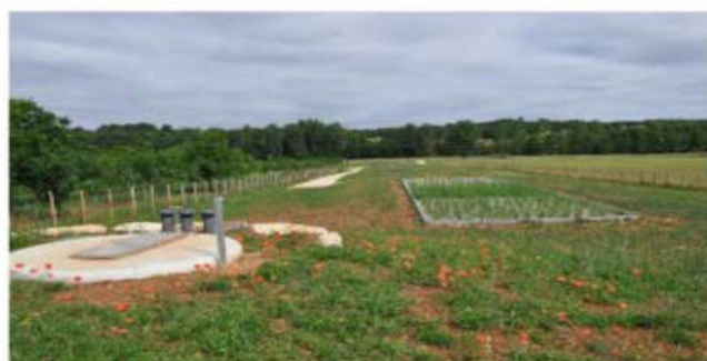
Nouvelle station d'épuration
