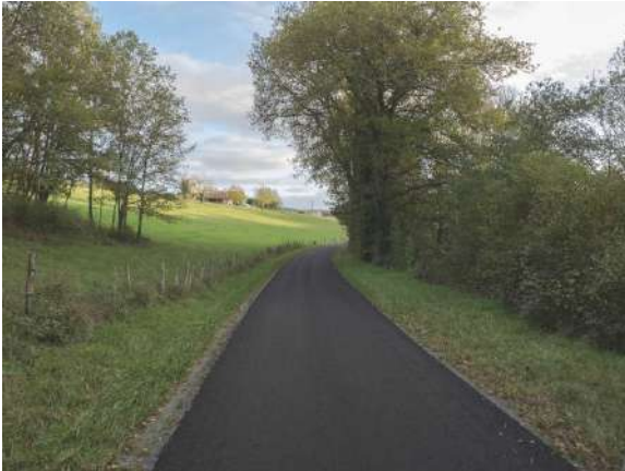
Route du Faureau : réfection de la voirie, une couche d'imprégnation + réalisation d'un enrobé à froid monocouche
