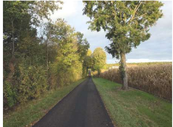
Route de la Reymondie : réparation en point à temps + réalisation d'un enrobé coulé à froid monocouche
