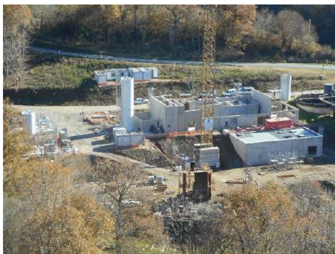
Future usine de traitement de l'eau de Pont Château
