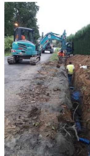
Pose de canalisation à Lanouaille
